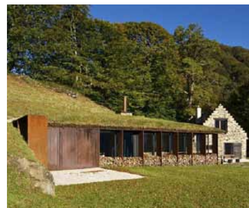
Extension de grange à Lesponne, architectes J. Puig-G. Pujol
